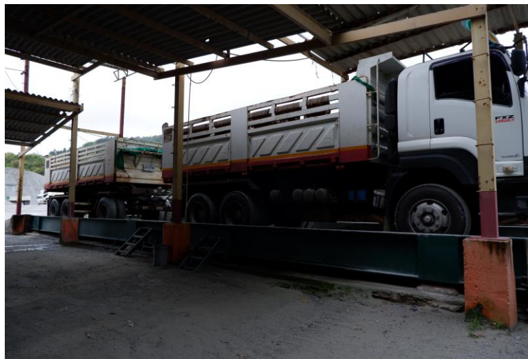
ภาพที่ 2-15 ชั่งน้ำหนัก/จุดคลุมผ้าและสเปรย์น้ำก่อนออกจากพื้นที่โครงการ
